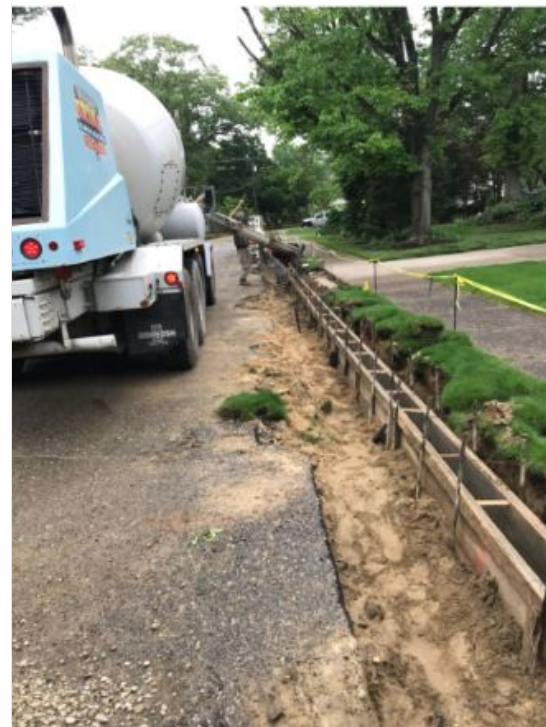
Figure 3: Concrete curb pour
